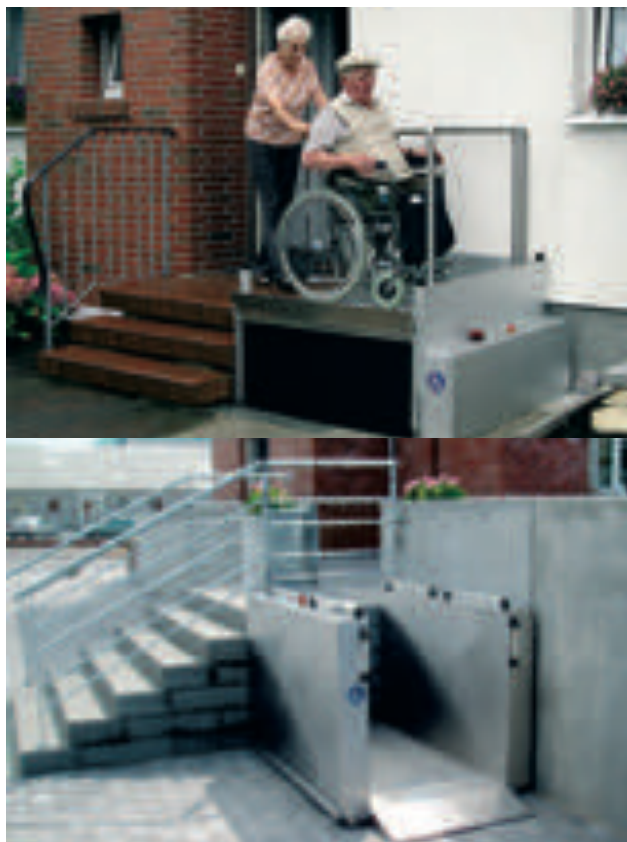
Obr. 2e: Zvislá zdvíhacia plošina je aj v interiéri pohodlnejšia ako šikmá schodisková plošina.
