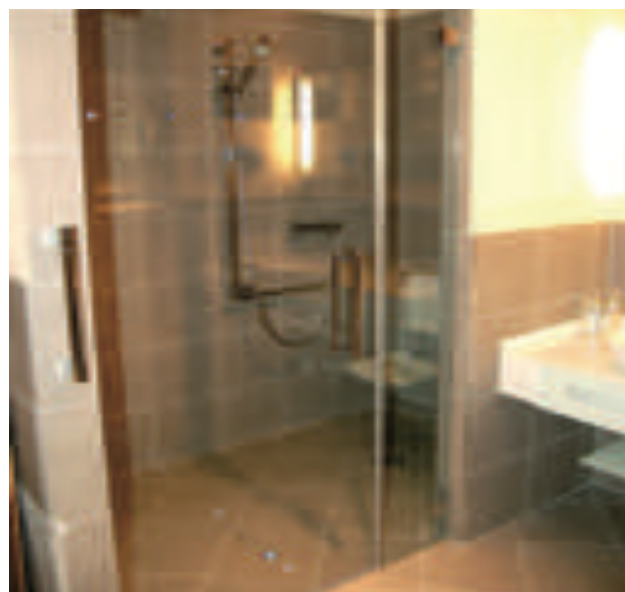
Obr. 3a, 3b. Príklad riešenia bezbariérovej sprchy, ktorá je odvodnená do podlahového vpustu alebo odtokového žľabu. Takto riešená sprcha je komfortná pre každého klienta.
